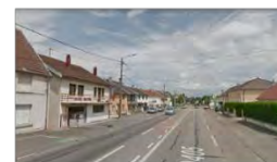
Zone UAd (Dole, Foucherans et Tavaux) axes structurants et sites à densifier
