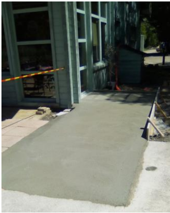
Accès rampe terrasse
