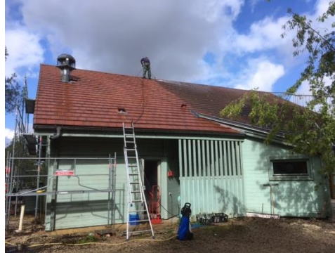
Nettoyage du toit
