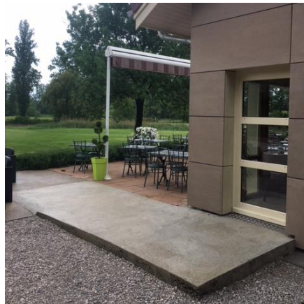
Rampe d'accès à la terrasse
