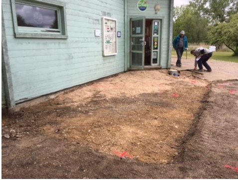
Travaux sur la rampe d'entrée
