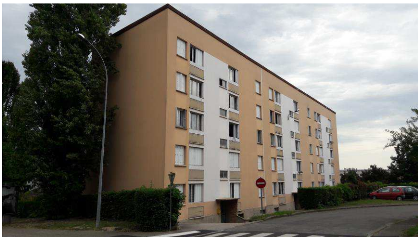
Bâtiment 1,3 et 5 rue Marquiset : 30 logements
