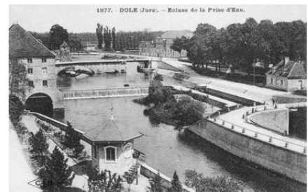
Écluse de la prise d'eau à Dole, 1877
