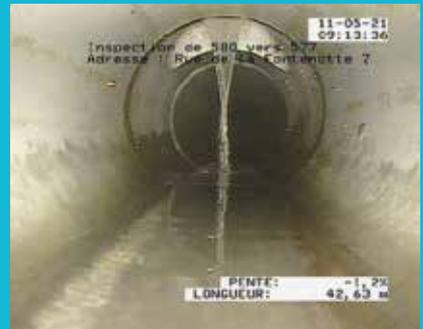
Infiltration d'eau dans une canalisation d'assainissement.
