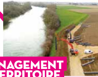
Travaux sur la digue de Champdivers.
