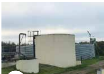
Station d'épuration Damparis
