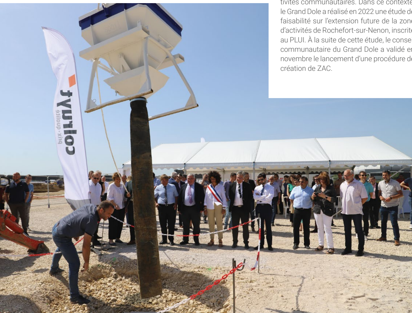
Pose de la 1 ère pierre de la nouvelle base logistique Colruyt
