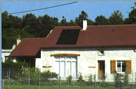
Un montage pour montrer que la pose de capteurs solaires entre dans la réflexion globale sur le projet afin de ne pas dénaturer la composition de la façade
