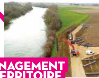
Travaux sur la digue de Champdivers.
