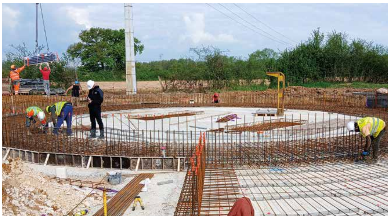
Travaux de reconstruction de la station d'épuration de Damparis, afin d'améliorer le traitement des eaux et préserver notre environnement.
