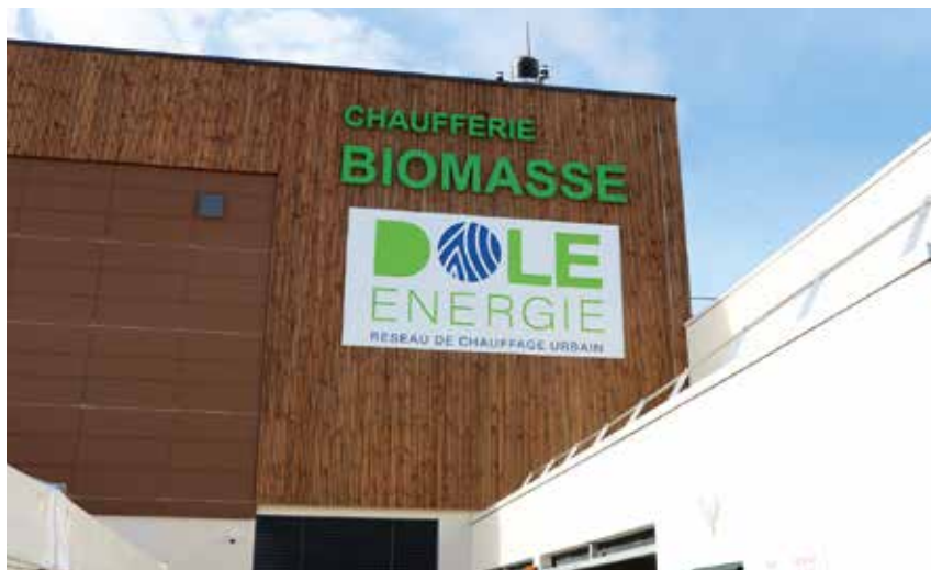
La nouvelle chaufferie biomasse de Dole, fonctionnant grâce à la combustion de bois local et alimentant le réseau de chauffage urbain de la ville, est un bon exemple d'énergie renouvelable.
