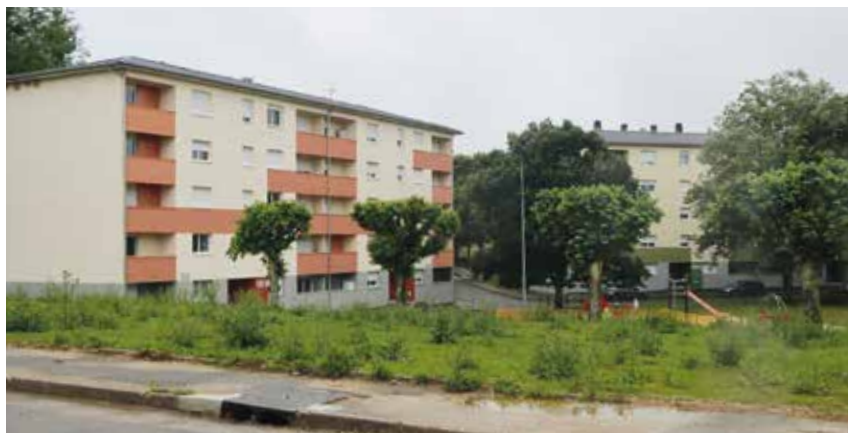
Rénovation des secteurs Descartes et Grands Champs aux Mesnils-Pasteur, à Dole.
