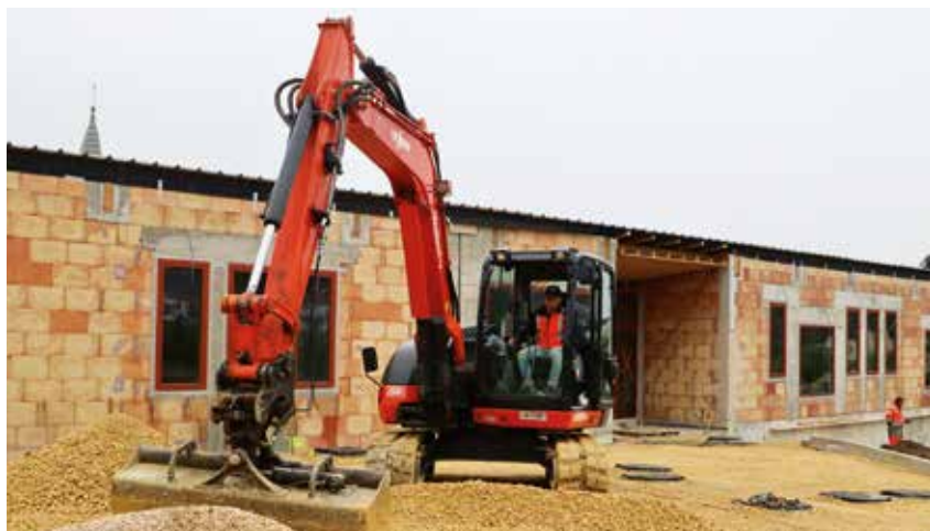
Pilotage des travaux au sein de l'accueil de loisirs d'Authume.
