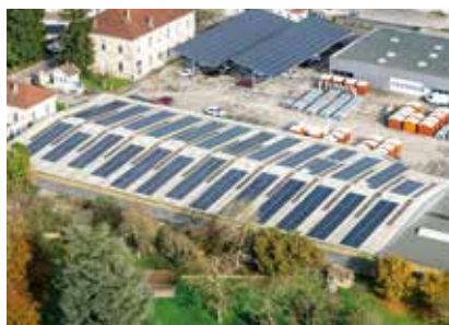
Panneaux photovoltaïques du Centre Technique Municipal (CTM) de Dole.
